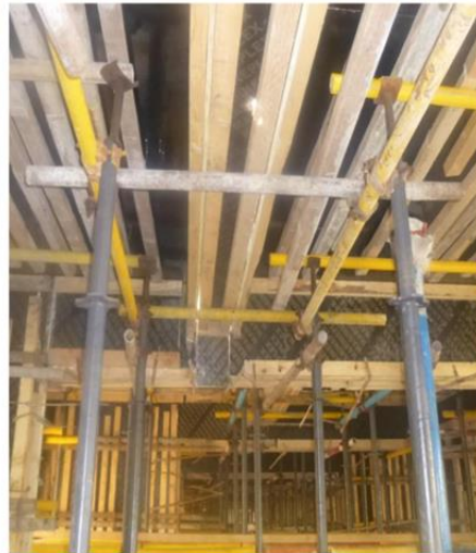
梁高小于 400mm 梁底搭设示意图
